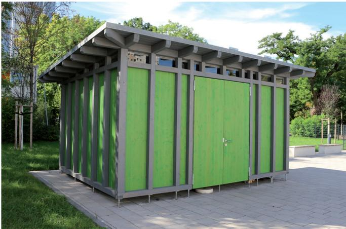
11 Gerätehaus mit Füllung aus Platten, sichtbare Pfosten
