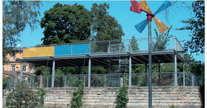
3 Stahlkonstruktion, obere Etage begehbar
