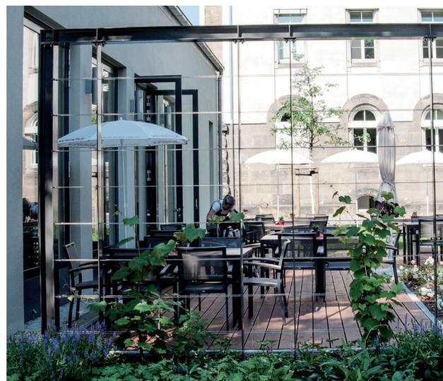
4 Stahlrahmen mit Drahtseilspalier
