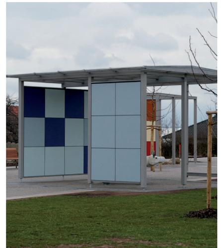
6 Dach aus Doppelstegplatten
